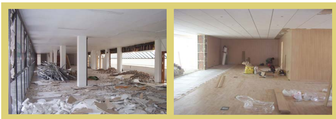
Obras de construcción de las nuevas oficinas del Consorcio de Transportes
